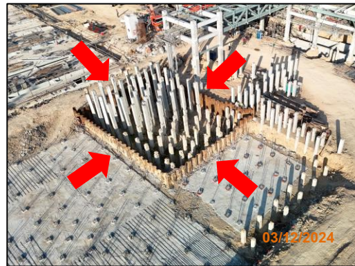
รูปที่ 2-68 กำแพงกันดินแบบเสาเข็มพืด (Sheet Pile Walls)
