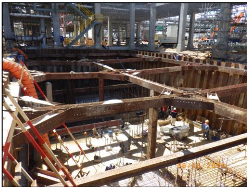
รูปที่ 2-68 กำแพงกันดินแบบเสาเข็มพืด (Sheet Pile Walls)
