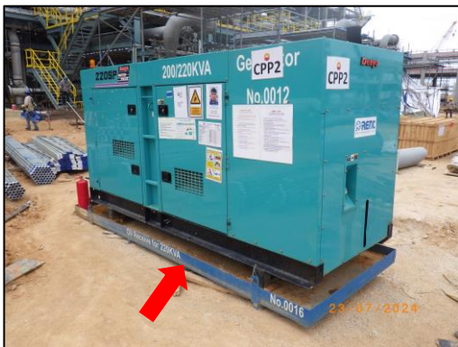
รูปที่ 2-19 ถาดรองน้ำมันเครื่อง บริเวณเครื่องกำเนิดไฟฟ้าดีเซล
