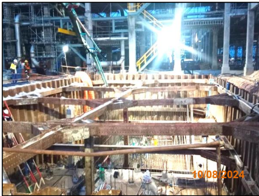
รูปที่ 2-67 ไฟส่องสว่างบริเวณหลุมลึก
