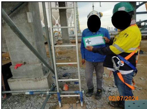
รูปที่ 2-63 การตรวจสอบสภาพนั้ร่ำนก่อนใช้งาน
