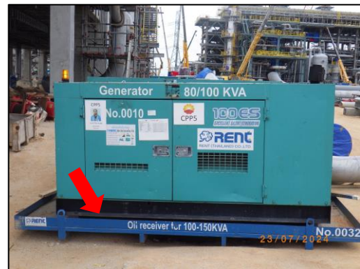
รูปที่ 2-19 ถาดรองน้ำมันเครื่อง บริเวณเครื่องกำเนิดไฟฟ้าดีเซล
