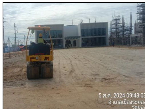
รูปที่ 2-1 การบดอัดดินให้เรียบร่อนก่อนเปิดพื้นที่ส่วนอื่น
