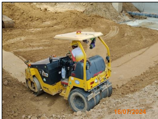
รูปที่ 2-1 การบดอัดดินให้เรียบร่อนก่อนเปิดพื้นที่ส่วนอื่น
